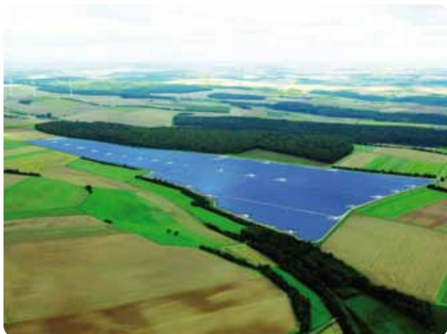
18,7MWp solární elektrárna v německém Thüngen
